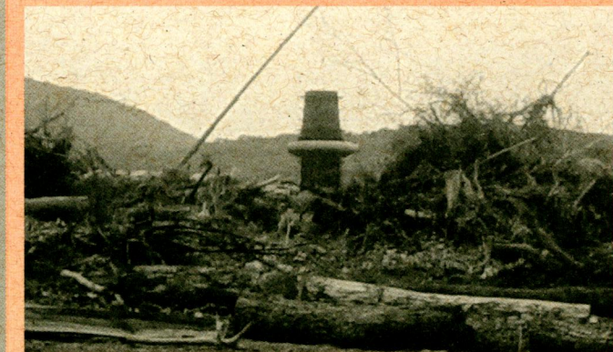
MMX está construindo usina na área de Maria Coelho
