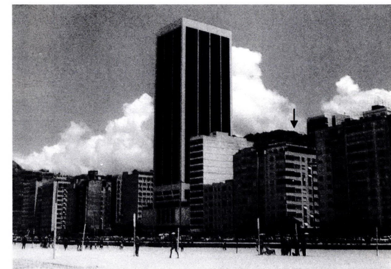
A Francesco Todesco & Cia. Ltda. construiu diversos prédios em Copacabana, nas décadas de 50 e 60, como o que está assinalado na foto, na Av. Atlântica.
